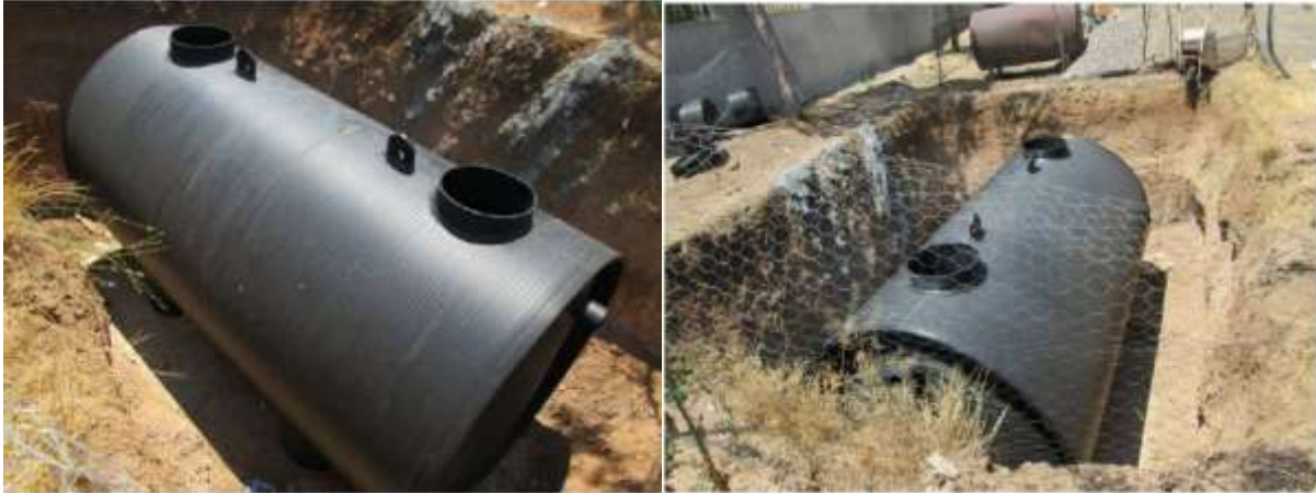
شکل ۳) جانمایی صحیح مخزن در ترانشه
