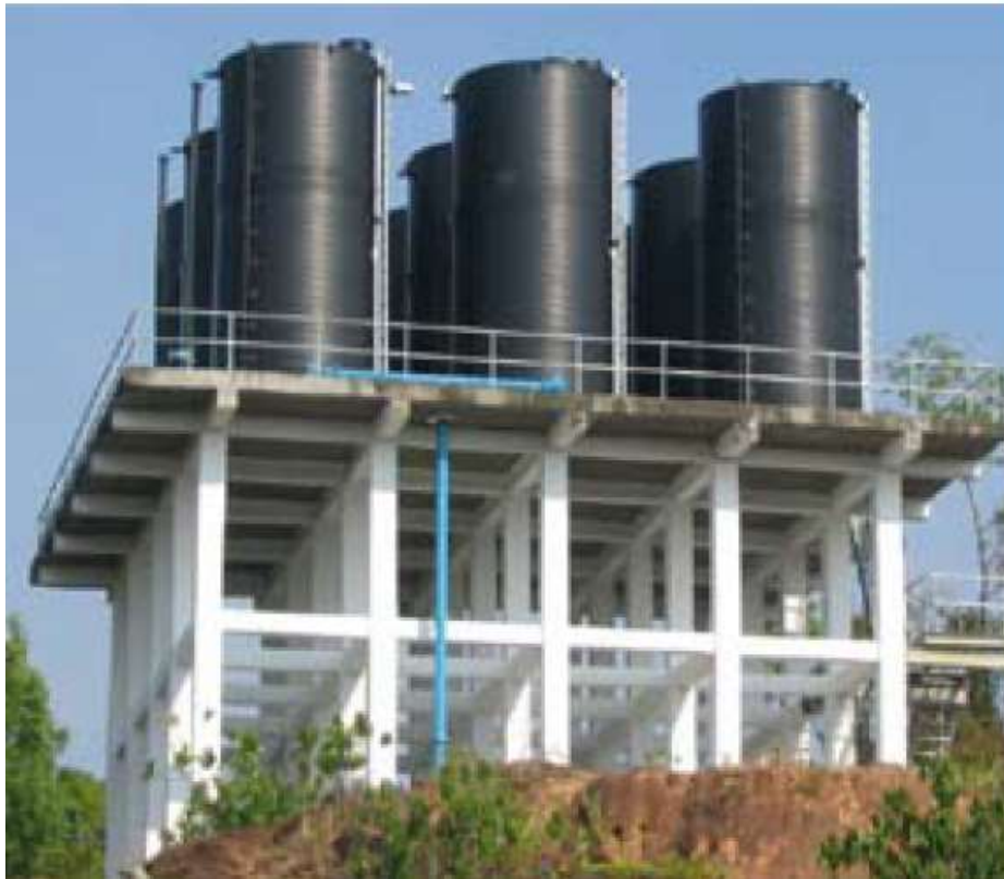
شکل ۶) نصب مخازن به صورت هوایی
