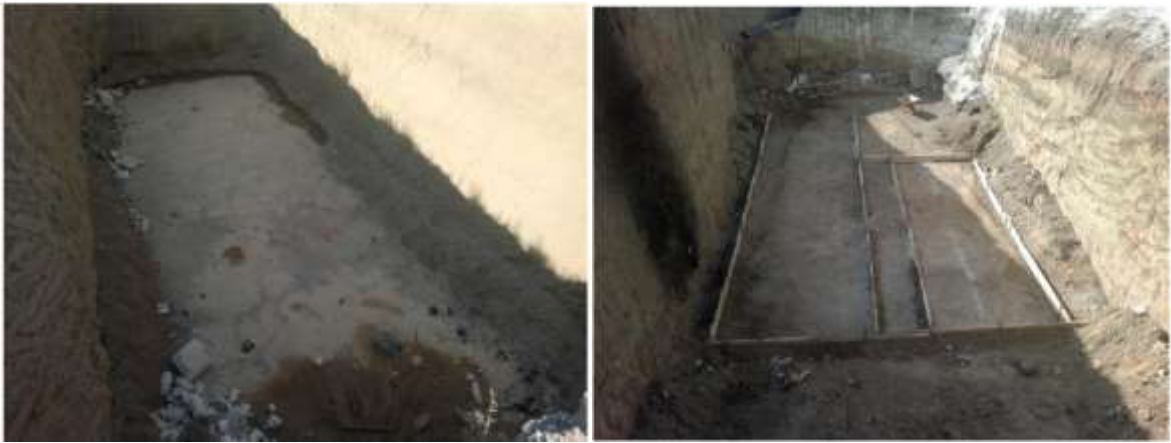
شکل ۱) خاکبرداری و اجرای بتن کف مخازن
