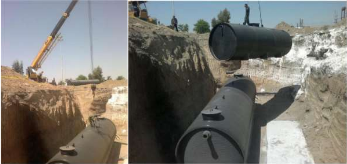
شکل ۲) جابه جایی صحیح مخزن
