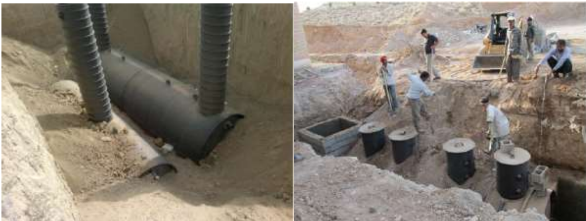
شکل ۴) پر کردن صحیح ترانشه
